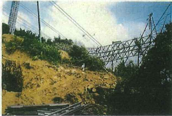
地震動による345kV鉄塔の倒壊 (1999年台湾集集地震)
