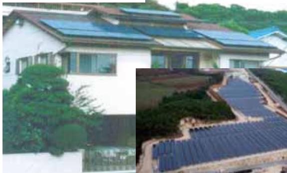
[住宅用システム]
